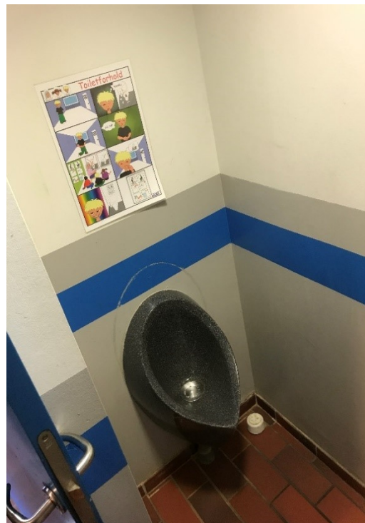
1. billede af Arenaskolen, drengesektionen ved mellemtrinnet, som gik fra 3 drengetoiletter til 2 (før-billede).
