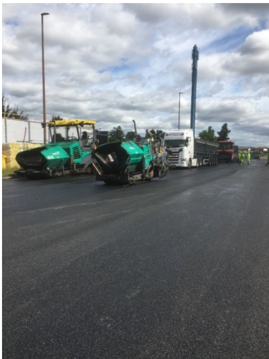
Billede fra asfaldudlægningen
