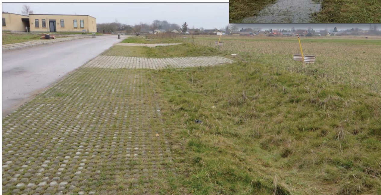
Figur 8.3: Eksempel på LAR løsninger i Tune NØ. Vejene afvander via vadi (en kombination af et trug og en rende med faskine under).
